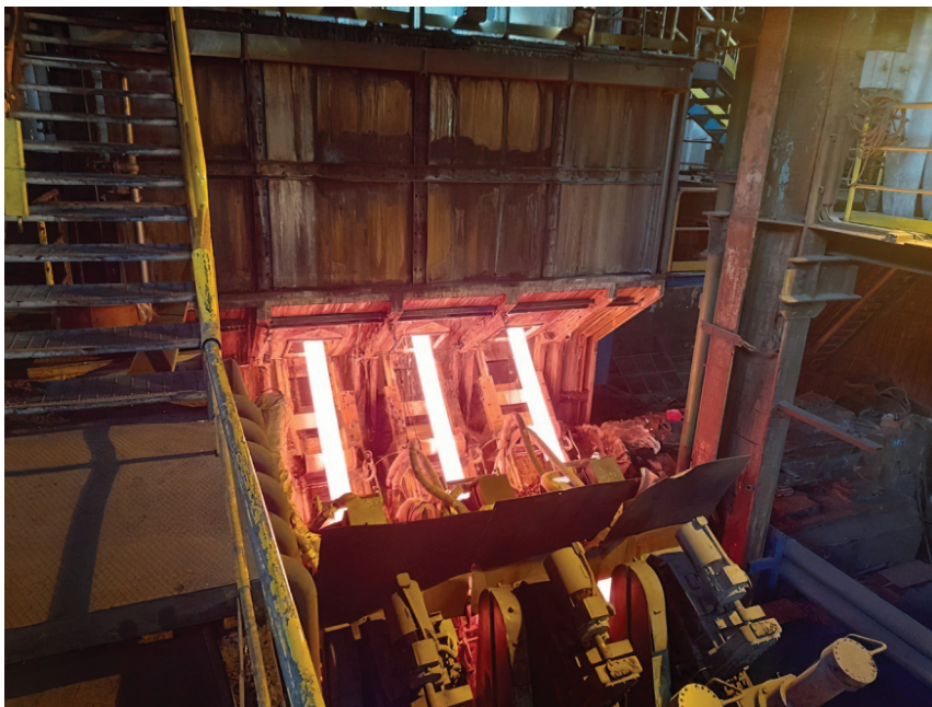
Slika 10. Postrojenje za kontinuirano lijevanje čelika u ABS Sisak, d.o.o., 2021.
