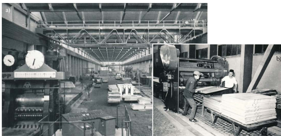
Slika 9. Hala tople valjaonice aluminija u TLM-u Šibenik (a) i prvi limovi aluminija (b) iz 1955. godine / Figure 9. Hot rolling mill hall of TLM Šibenik (a) and the first aluminium sheets (b) from 1955
